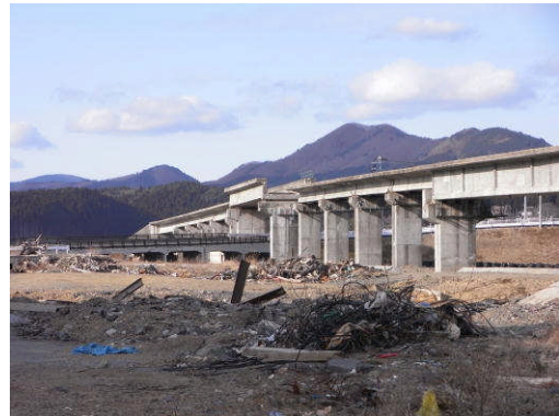
気仙沼線の橋梁
