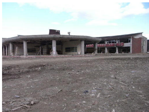
die Ruine der Ookawa-Grundschule, von der nur noch das Gerüst ueblich geblieben ist
